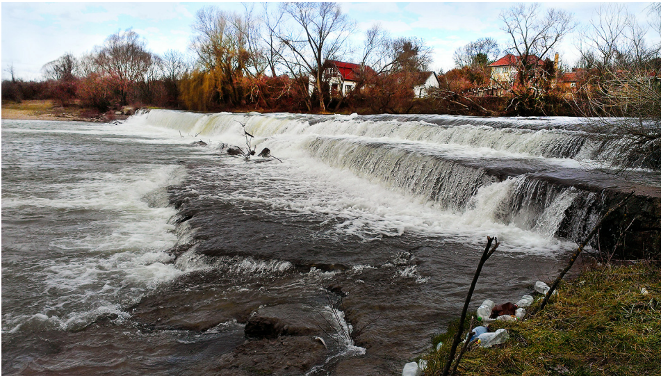
Fig. 4. Barrage area at winter in a overflow period 4. ábra. A gát környéke télen áradáskor
