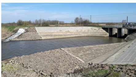
1. ábra. A Nagykunsági-főcsatorna kétpói kövezett szakasza
