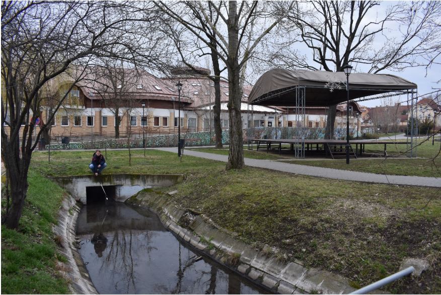
A termálvízkifolyó kezdeti szakasza (Juhász Lajos felvétele) The initial stage of the thermal water outlet (Photo: Lajos Juhász)
